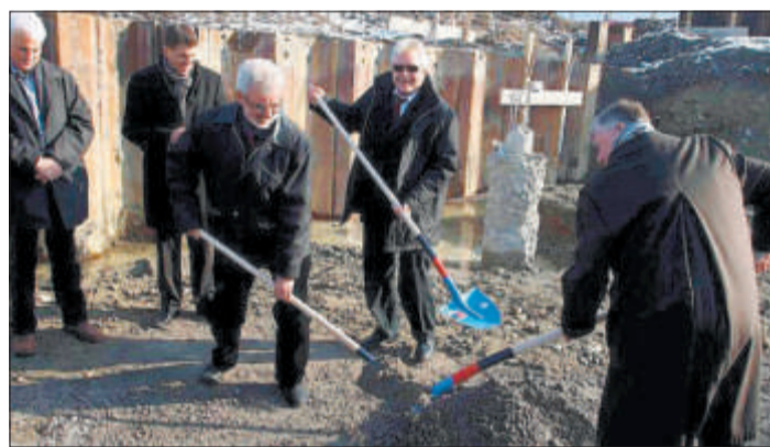
Josef Burri (links), Peter Pschesna und Ernst Schaufelberger vergraben die Stahlkassette auf dem Feldmatt-Bauplatz. BILD BB
