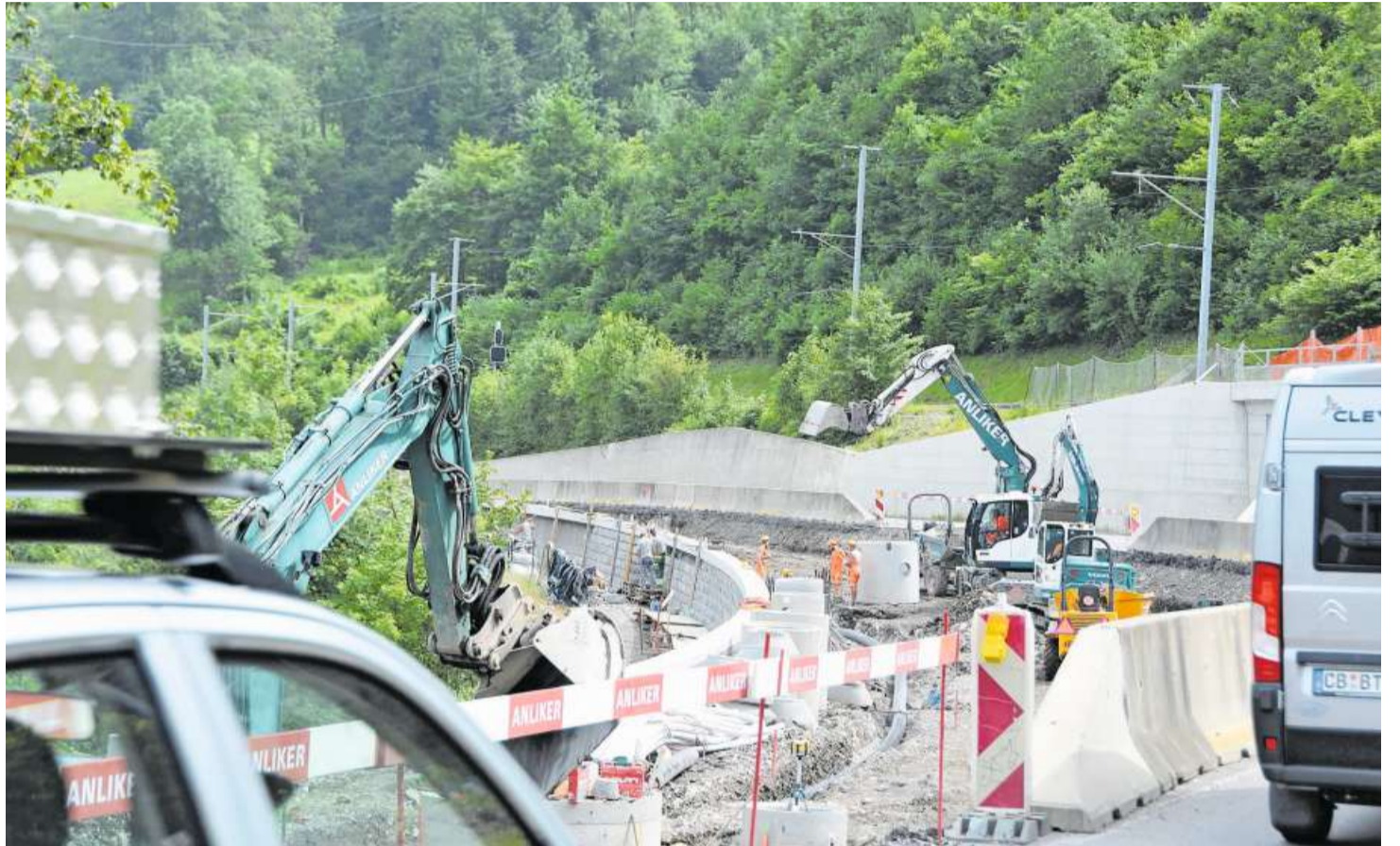
Die Brünigstrasse wird verlegt, um Platz für die Zufahrtsstrasse zum Südportal des Kaiserstuhltunnels zu schaffen. Die Autofahrer müssen sich mit einer Fahrspur begnügen. Bild: Matthias Piazza (Kaiserstuhl, 21. 6. 2023)
